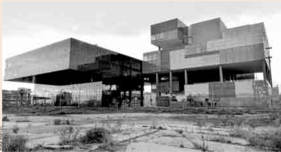
A la izquierda, edificio donde se instalará la Agència Tributària; a la derecha, futura sede de Agbar.
